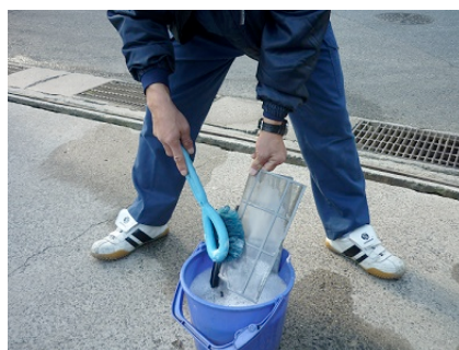
・空調機器フィルターの定期清掃
